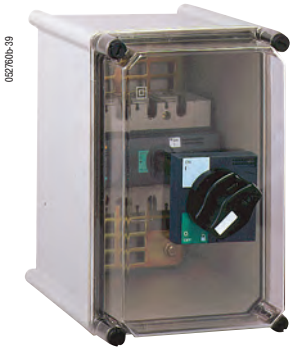
Щит местного секционирования
