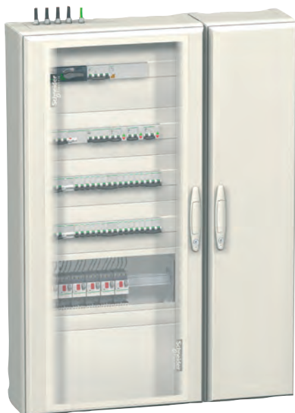
Вводной аппарат в силовом распределительном щите Prisma Plus G IP55
