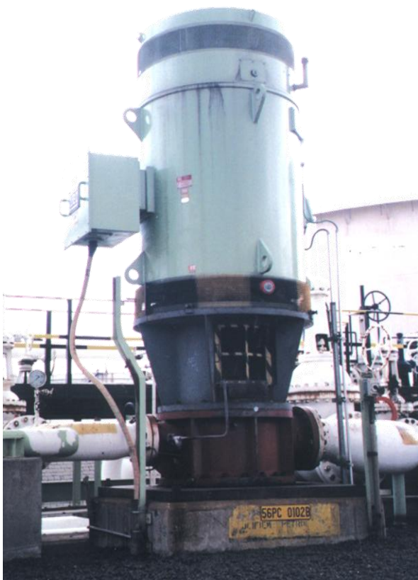
▲ 900 кВт, 4 пол., 6.6 кВ, 50 Гц MGF500, асинхронный двигатель Применение: нефтехранилище – SASOL Южная Африка
