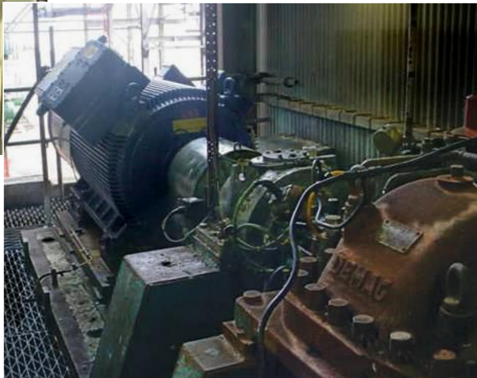
1100 кВт, 4 пол., 3.3кВ, 50 Гц ▶ HGF, асинхронный двигатель Применение: компрессор на нефтеперерабатывающем заводе Fawley – Southampton ESSO
