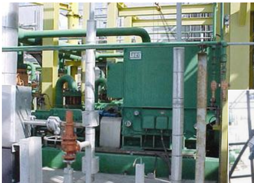
◀ 5 x 1500 л.с. , 2 пол., 4.0 кВ 60 Гц MGF450, асинхронный двигатель Применение: насосы на платформе Petrobras P-35
