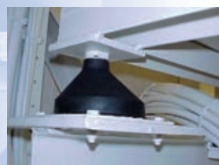
Демпферы, изолирующие вибрацию и ударные нагрузки
